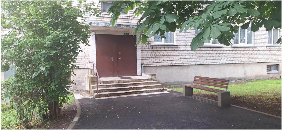
Vērtētā dzīvokļa īpašuma daudzdzīvokļu ēkas ieeja kāpņu telpā
